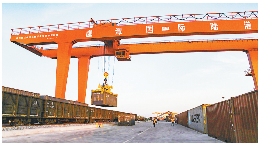
鹰潭国际陆港中欧班列正在吊装货物
