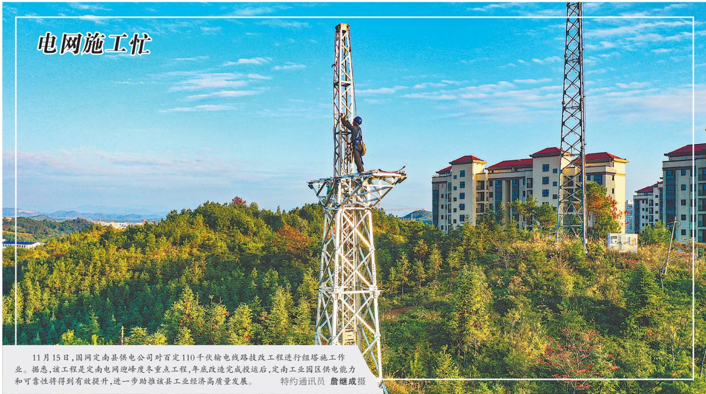
11月15日，国网定南县供电公司对接百定110千伏输电线路技改工程进行组塔施工作业。据悉，该工程是定南电网迎峰度冬重点工程，年底改造完成投运后，定南工业园区供电能力和可靠性将得到有效提升，进一步助推该县工业经济高质量发展。 特约通讯员 詹继成摄
