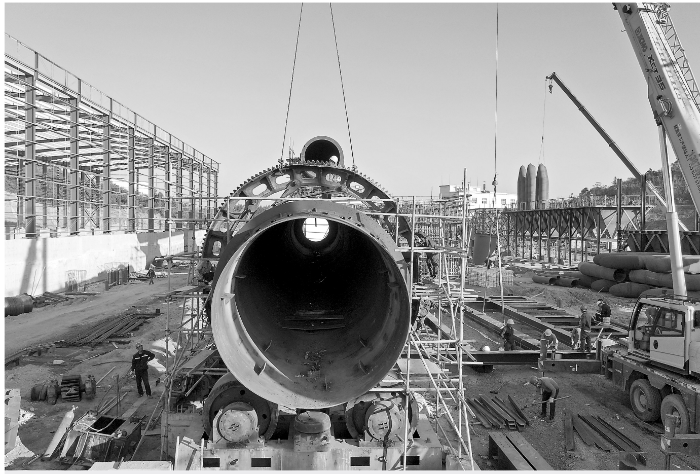
近日，在萍乡市湘东工业园的龙懋环保科技有限公司项目建设现场，各类施工机械运转不停，工程车辆来回穿梭，一派繁忙景象。近年来，湘东工业园以项目建设为抓手，全力推动园区经济提质增效。
