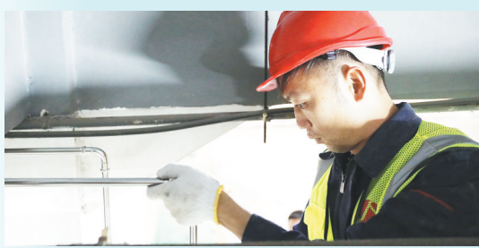
南昌水业集团专业技术人员在安装直饮水食品级304不锈钢循环管道
