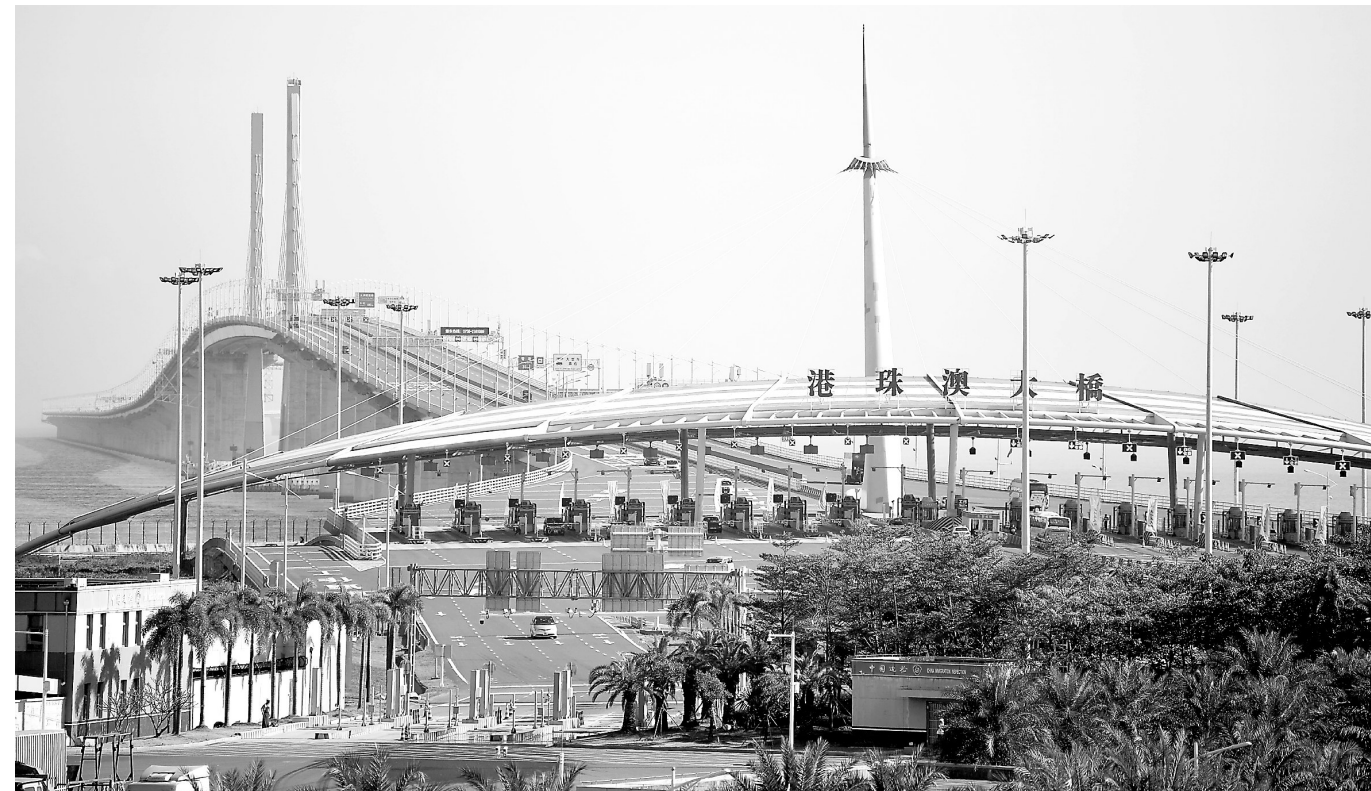
▲这是12月15日拍摄的港珠澳大桥。新华社记者 邓华摄
