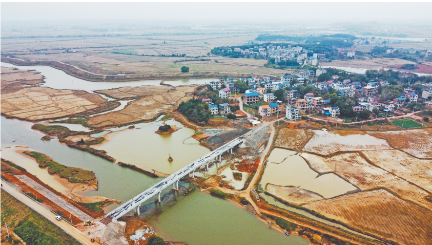
青岭桥即将通车。
