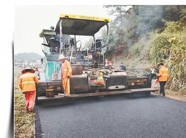
赤谷乡田西村道路“白改黑”施工现场。
