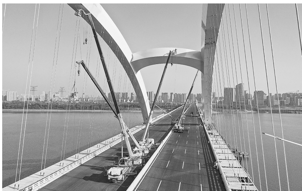
12月24日，在南昌复兴大桥项目建设现场，中国铁建大桥局施工人员正在对桥体进行涂装作业。目前施工单位正抢抓进度，全力完成年底主线贯通任务。本报全媒体记者史港泽摄
