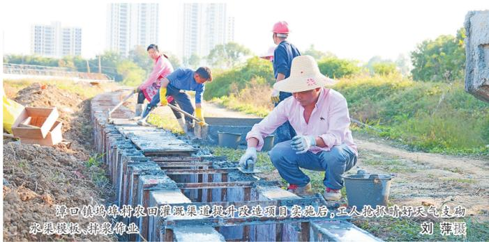
潭口镇坞埠村农田灌溉渠道提升改造项目实施后，工人抢抓晴好天气支砌水渠边墙、拌浆作业。刘 燕 摄
