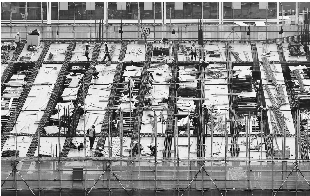
1月8日,南昌市第十中学经开高中部项目施工现场,工人们正在绑扎钢筋。该项目占地面积约155.4亩,规划建设48个班,计划今年8月完成建设。 本报全媒体记者 洪子波摄
