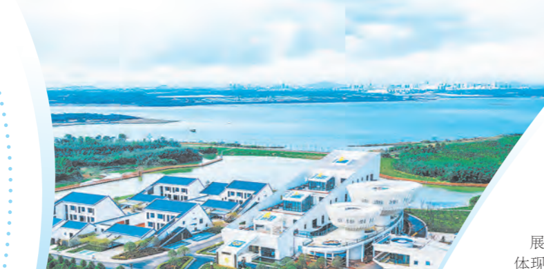
共青城市总仓项目
