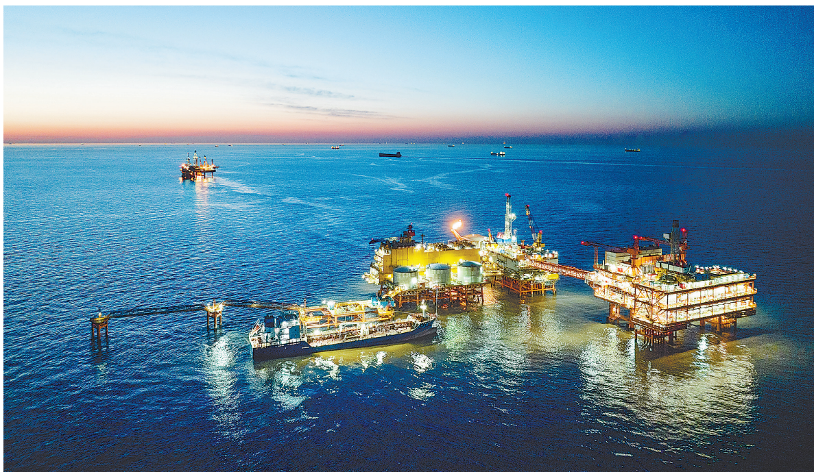
这是1月25日拍摄的埕北油田全景(无人机照片)。
