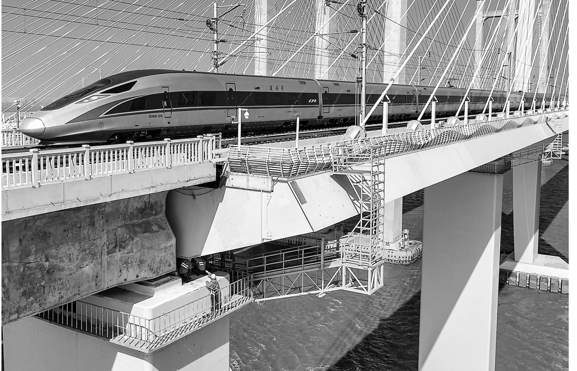
1月26日,复兴号动车组列车经过福厦高铁泉州湾跨海大桥厦门工务段作业人员检修点(无人机照片)。
