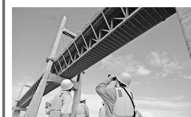
1月26日,福州工务段工人乘船在海面通过望远镜瞭望检查平潭海峡公铁大桥桥墩。
