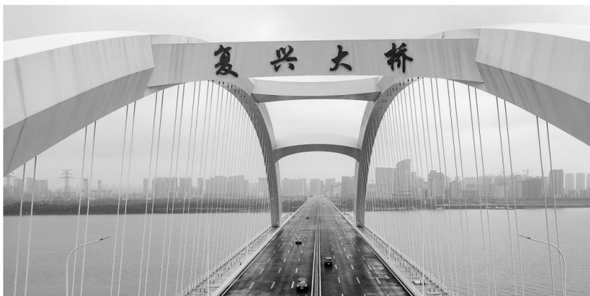
2月6日,南昌复兴大桥项目主线通车,为5月全线通车打下坚实基础。复兴大桥是南昌市第八座跨赣江桥梁,大桥全长4.7公里,主桥为中承式系杆拱桥,采用双向八车道并设置独立过江慢行系统。全线建成后,将完善南昌市“一江两岸”快速交通体系。
