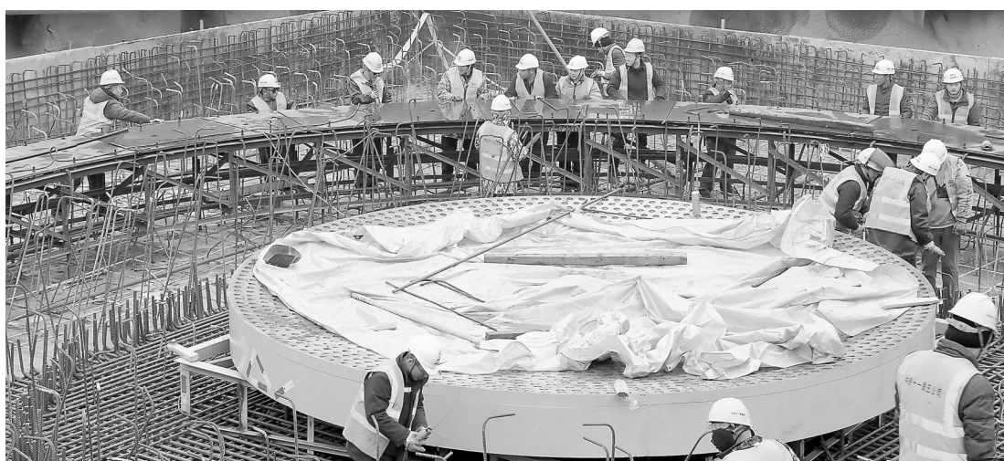
2月9日,在赣江新区中医药科创城阳光大道施工现场,为推进施工进度,春节期间,50余名施工工人一同坚守,确保这条快速串联赣江新区与周边地区的交通干道年底全面贯通。 本报全媒体记者 杨静摄
