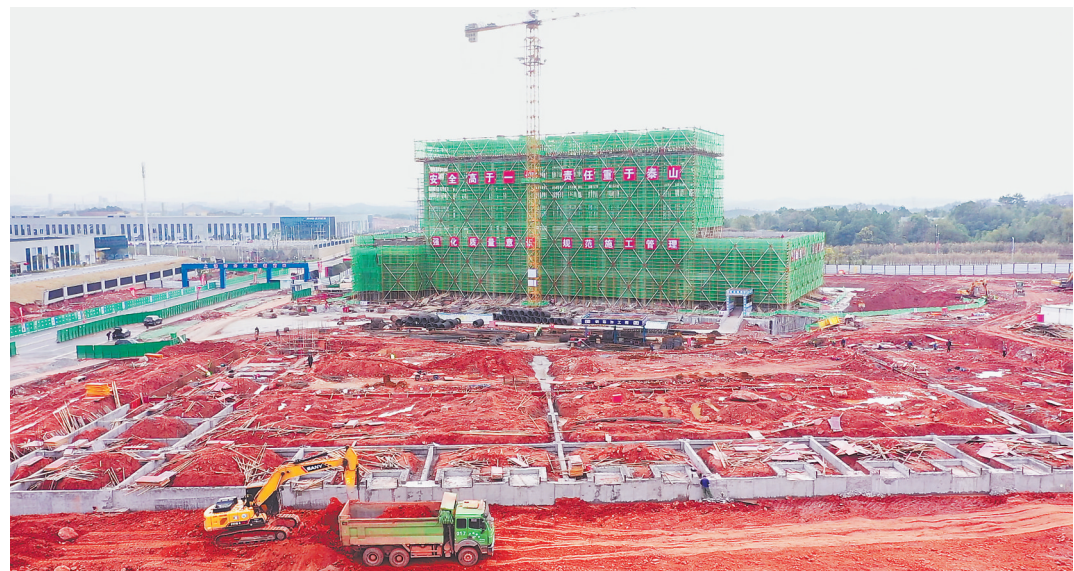
2月18日,上饶市2024年一季度重大项目联动开工暨“十百千万”工程动员大会在上饶经开区举行。图为建设正酣的市属重点项目——上饶综合保税区项目现场。 本报全媒体记者 余燕摄
