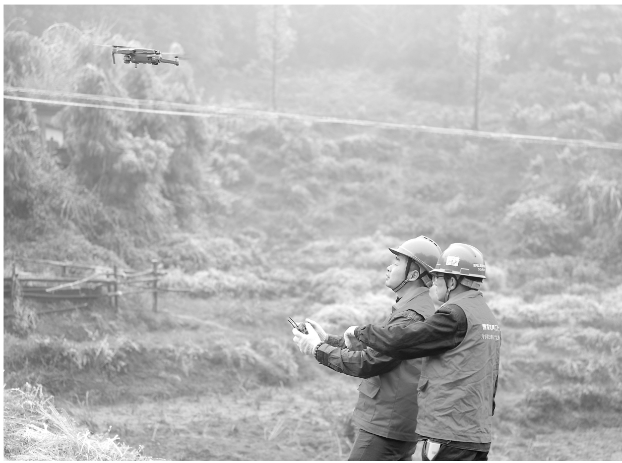
近日,国网赣州市上犹县供电公司安排人员,采取“人工巡视+无人机巡视”的方式,对高海拔地区供电线路设备进行覆冰隐患排查,保障电力安全可靠供应,确保群众用电无忧。
