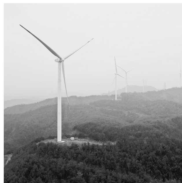
2月27日，在抚州市东乡区小璜镇余家村连绵不断的山顶上，18台风电机组正在转动发电，构成了一道“绿色能源”风景线。特约通讯员 饶方其摄
