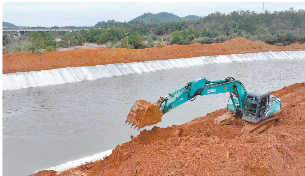
2月27日,在永丰县佐龙乡五石村,工人操作机械对新建灌溉渠道进行扫尾施工,保障春耕生产灌溉用水。 通讯员 刘浩军摄
