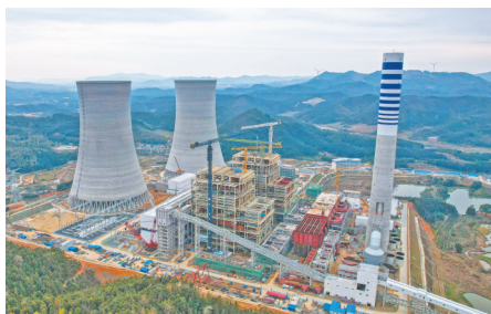
大唐新余第二发电公司2×100万千瓦清洁高效煤电项目建设现场 凌厚祥摄
