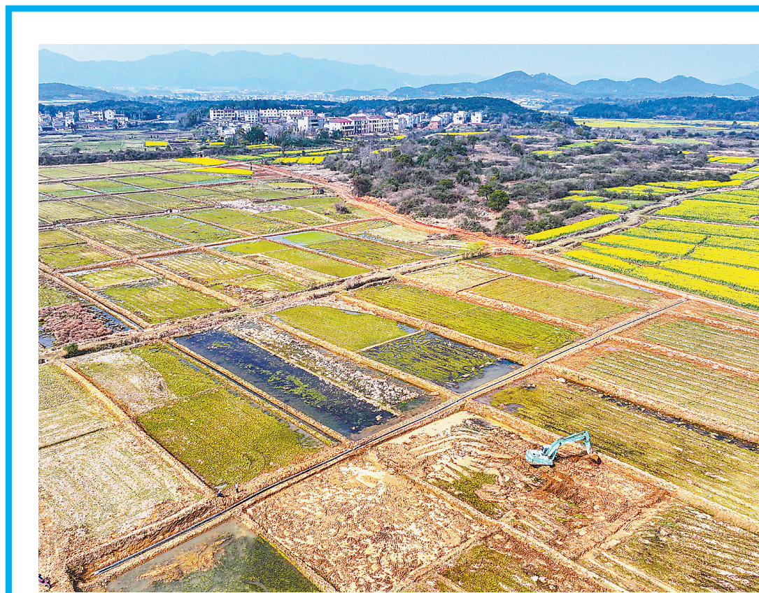
▲ 3月8日，高安市独城镇南湖村李家村小组，大型机械正在进行翻挖整理作业，高标准农田建设现场一派繁忙景象。 通讯员 胡可欣摄
