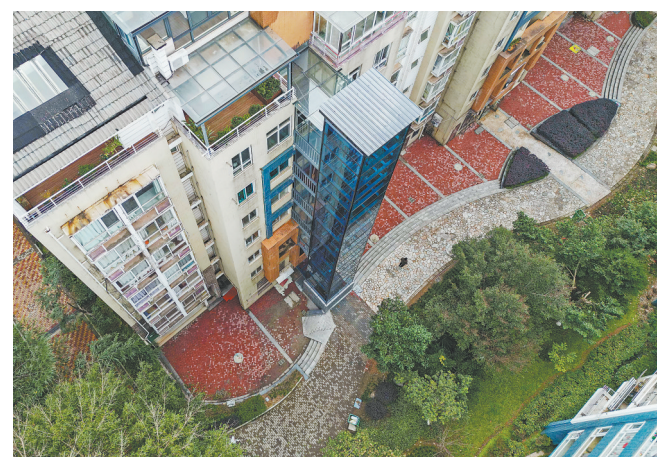
日前，在赣州市章贡区蔚蓝半岛小区，8部外挂和内嵌式电梯相继投入使用，有效解决了老旧小区高层住宅居民上下楼不便的问题。 本报全媒体首席记者 李勤摄
