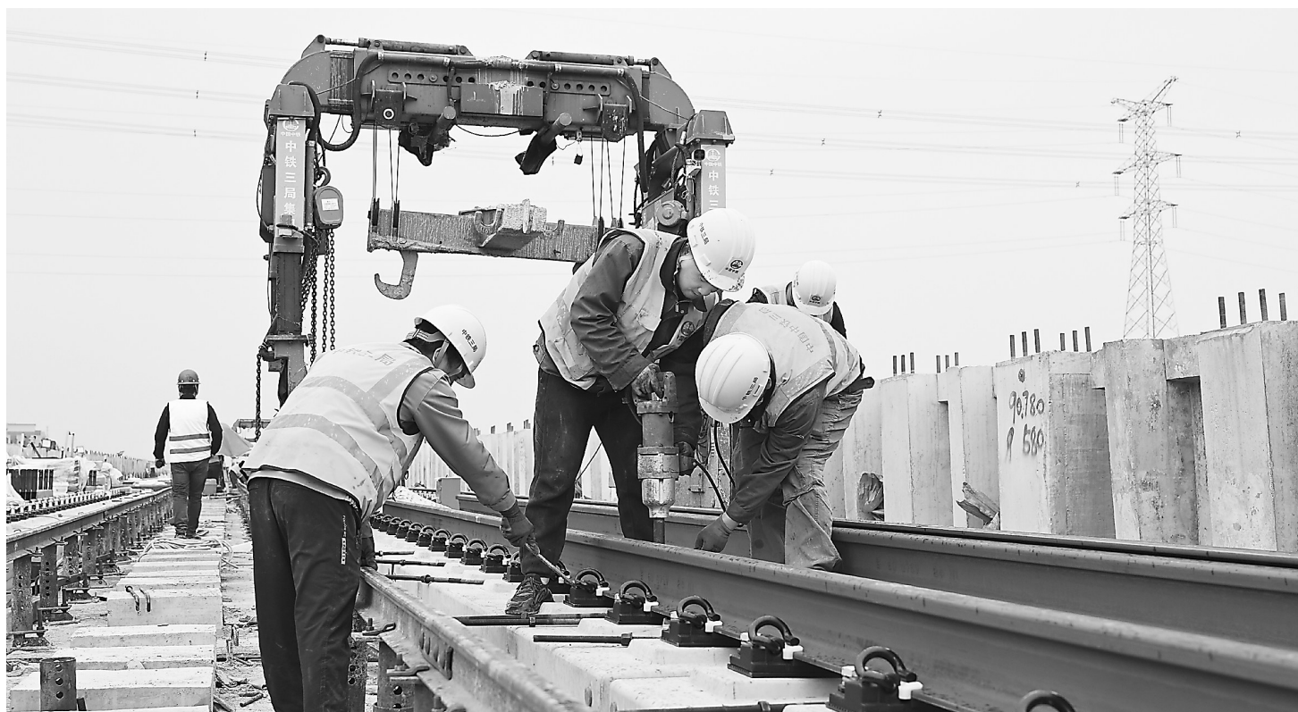
3月13日，在南昌地铁1号线北延线施工现场，工人们正在进行铺轨施工作业。据悉，1号线北延线始于昌北机场站，止于双港站，全长约16.9公里。目前，工人正加班加点赶进度，确保工程如期完成。
