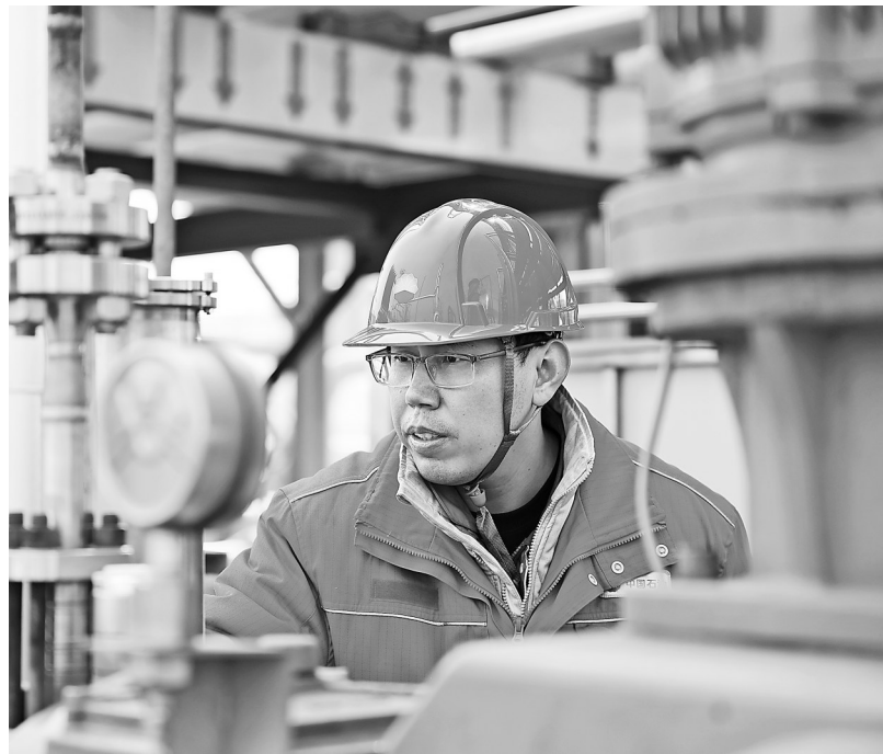
大港油田板南储气库运维工程师在生产装置区查看设备设施运行状态(2024年3月10日摄)。
