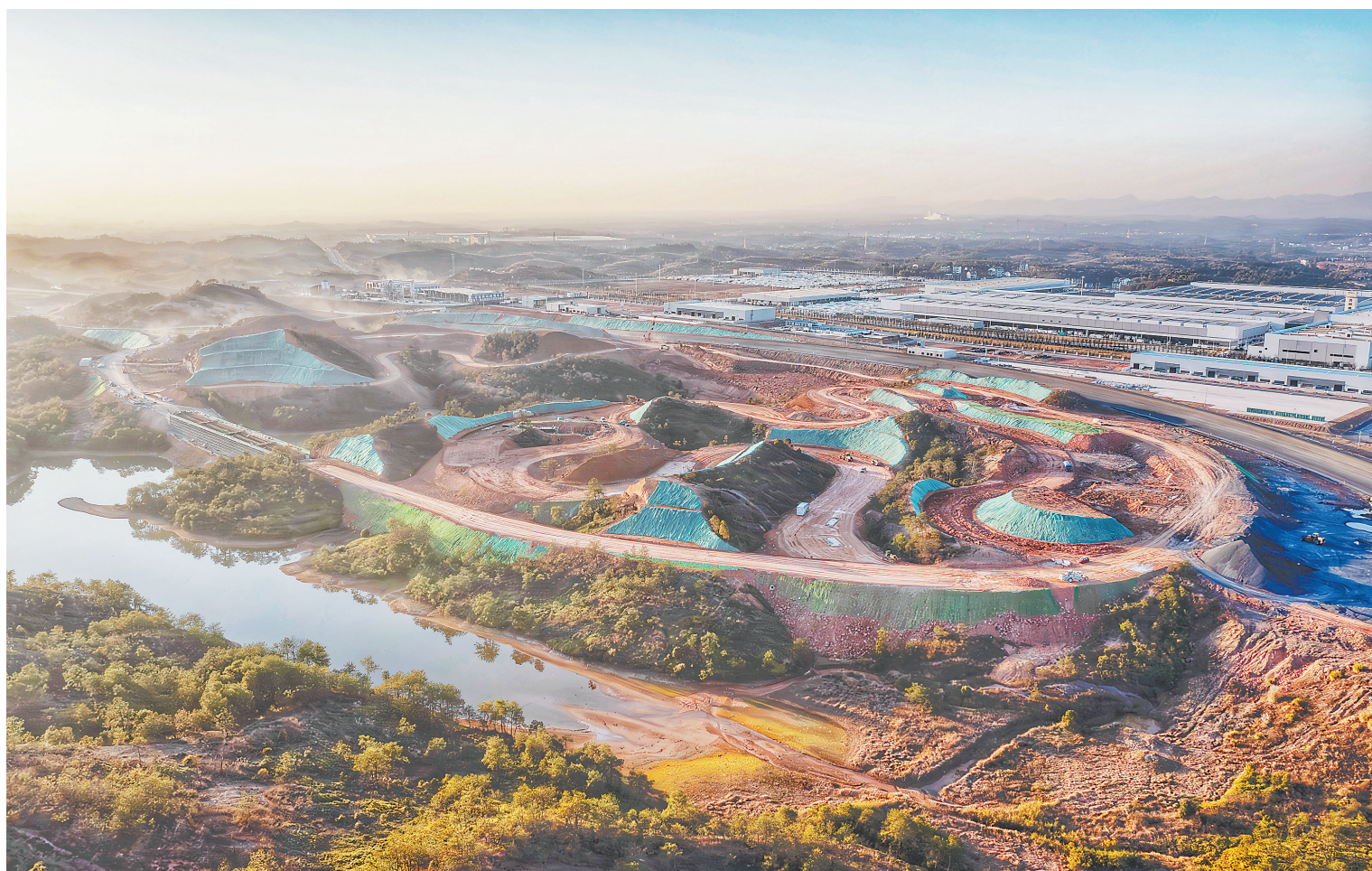
2023年12月26日,江西上饶汽车试验场的干湿操纵性路面测试区正在加紧建设中。
