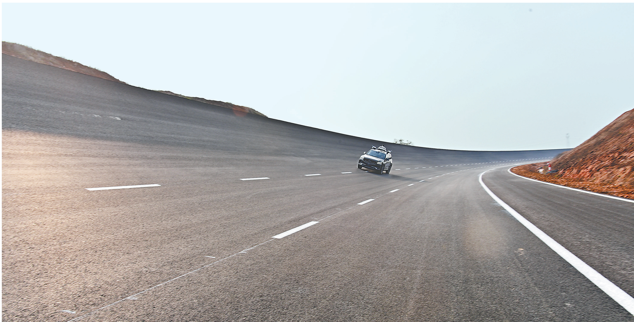
3月11日,位于上饶经开区的江西上饶汽车试验场,车辆在倾角达44.43度的高速环道上进行试跑。
