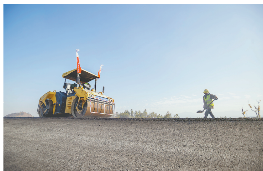
2023年12月26日,工人抢抓工期,保障测试车道工程进度。
