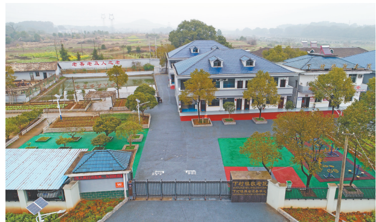
俯瞰敬老院，犹如一座农业庄园。 本报全媒体记者 付强 摄
