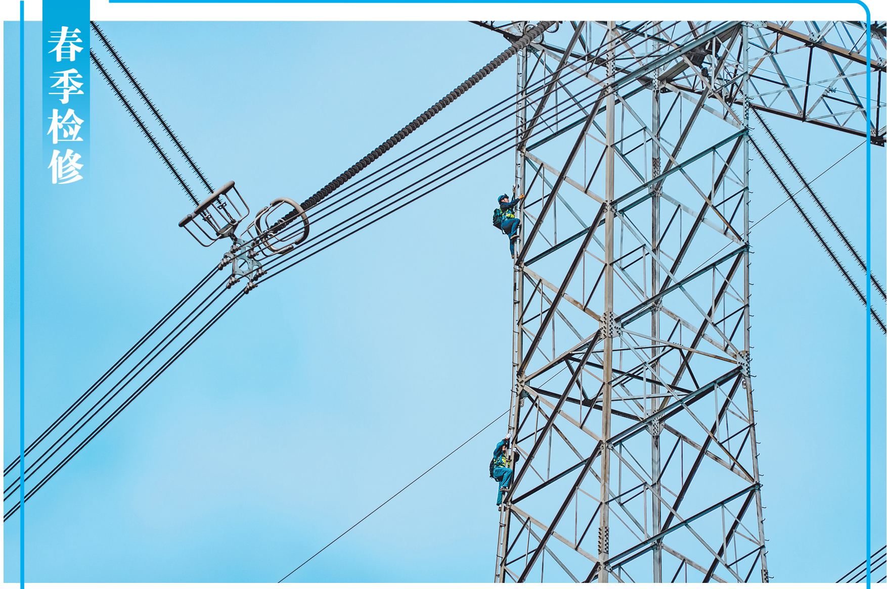
3月26日，工作人员正在对上饶市信州区内的宾金特高压线路进行年度计划检修，提升输电设备主体安全性，为电网迎峰度夏做好准备。 本报全媒体记者 朱兆恺摄
