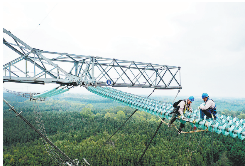
3月26日,江西省800千伏黄金线上高县徐家渡镇下兰村段,省送变电工程有限公司的工人正在更换绝缘子,提高电网供电可靠性。特约通讯员 陈旗海摄
