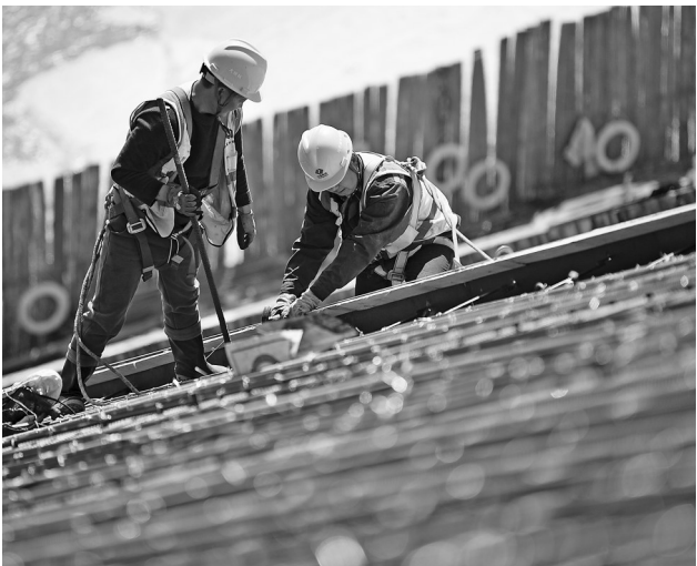
4月1日，玛尔挡水电站工作人员在坝体上施工。
