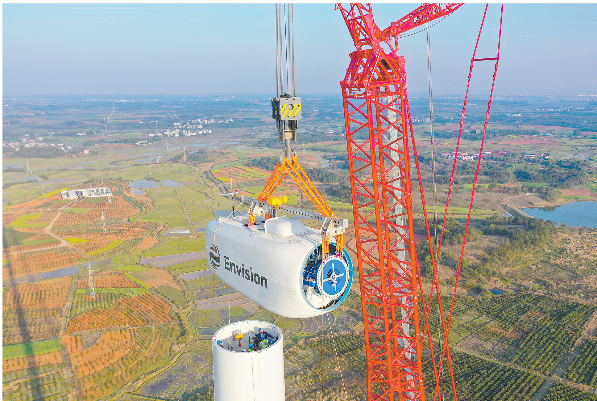
3月26日，高安市祥符镇160米高空，工人正在安装110吨重的风机机舱。
