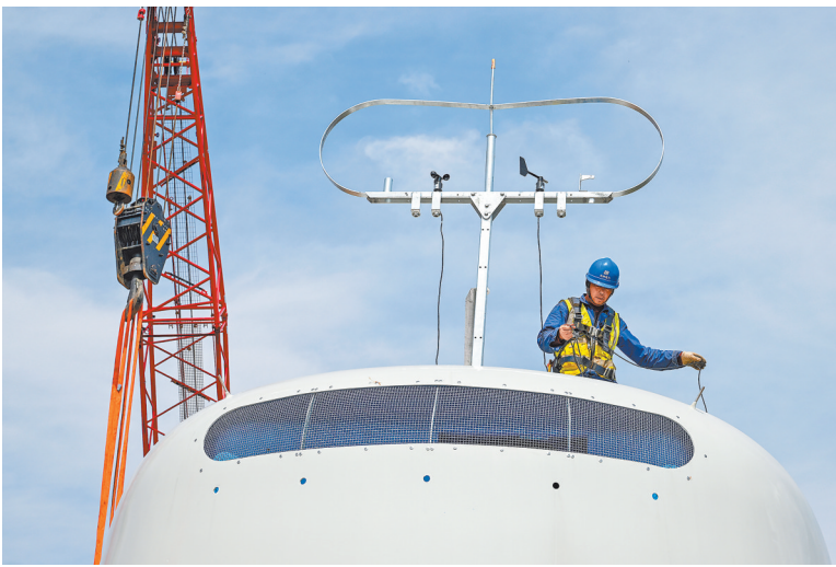
工人在机舱顶部安装风向标、风速仪和航空灯。
