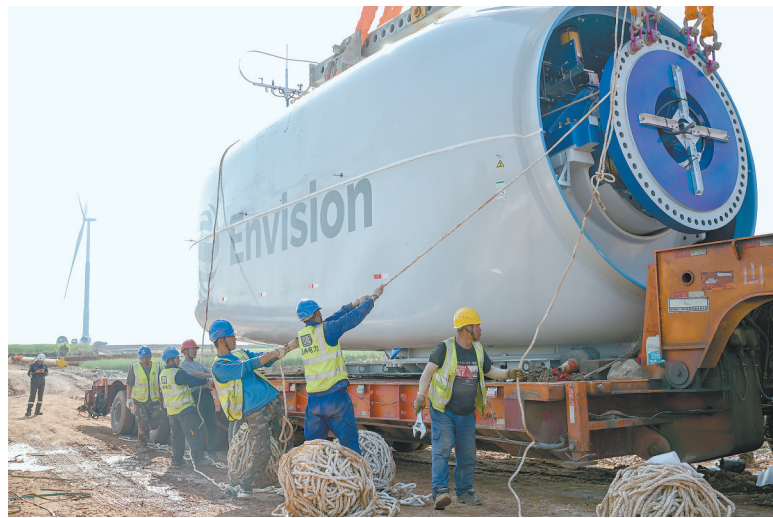
工人齐心协力，利用绳索控制方向，准备将风机机舱吊起。
