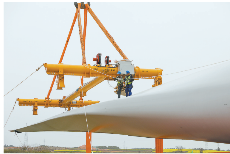
工人将风机叶片“五花大绑”，准备吊装。
