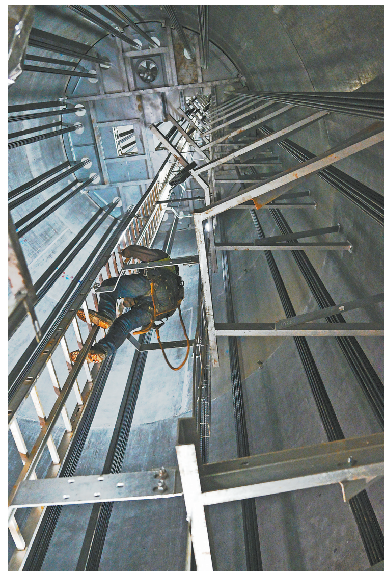
工人需要花费40分钟爬上160米高的塔筒，安装风机机舱。
