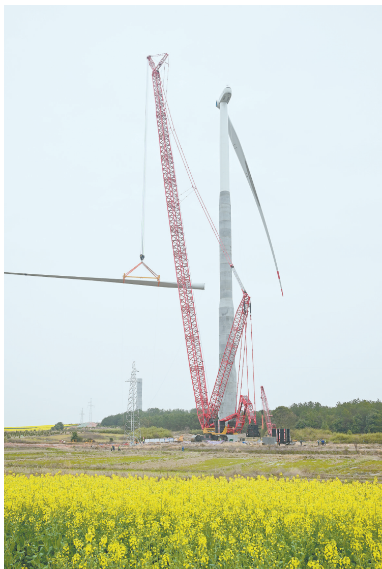
3月14日，高安祥符平价风电场项目施工现场，长达98米的风机叶片被缓缓吊起，随后将进行安装。
