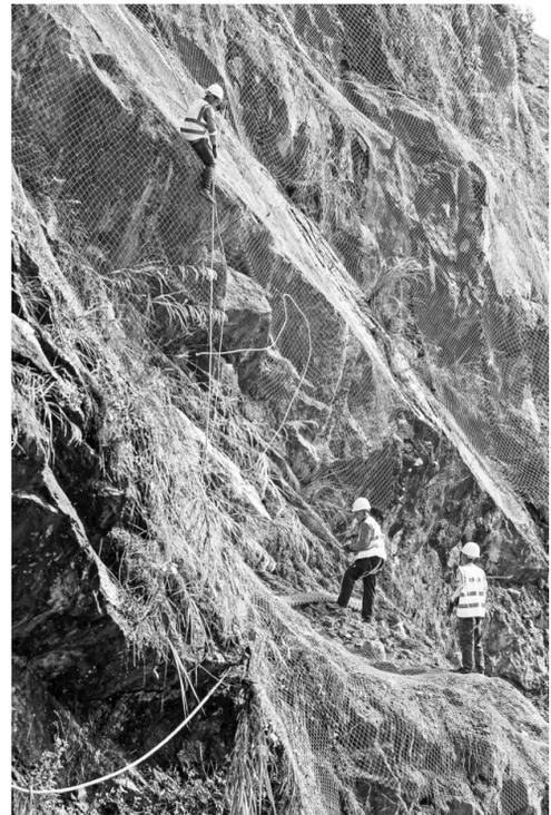
5月6日，定南县省道S456线仙岭路段公路灾害防治工程施工现场，工人正在一处峭壁路段安装防落石钢索网。随着雨季的到来，为防止公路山体高处的石层崩塌、石块滚落，该县采取多种方式消除安全隐患，保障沿线路人和车辆的通行安全。
