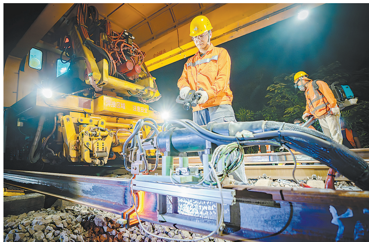
5月14日,九江西站附近,中国铁路南昌局集团有限公司鹰潭工务机械段职工正在实施钢轨焊接作业。据了解,京九铁路江西段2024年第一阶段集中修施工自5月9日开始持续至7月底。施工完成后,将进一步提升京九铁路线路设备的安全性和稳定性。
