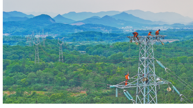
5月10日,在瑞昌市黄金乡110千伏输电变电工程项目施工现场,国网瑞昌市供电公司的电力工人在紧张作业。工程完工后,将更好地满足沿线企业、居民生产生活用电需求。 本报全媒体记者 曹诚平摄
