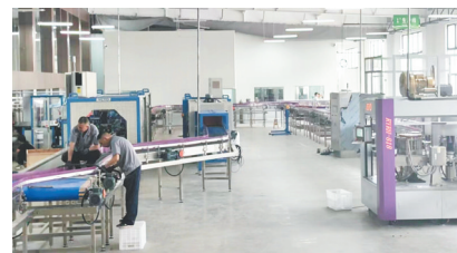
江西都夏园食品有限公司厂区内，工人们正在紧锣密鼓地安装富硒蔬菜加工生产线
