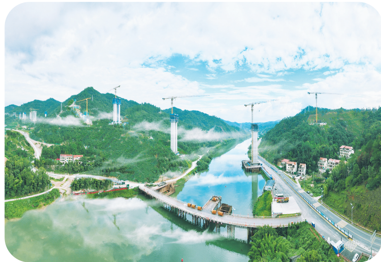
遂大高速江西“第一高墩”上犹江特大桥 陈建平摄
