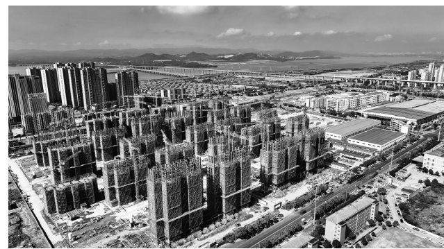
5月25日，位于九江经济技术开发区的“安永人家”四期保障房建设项目正在加紧施工，建成后可提供保障房2300套。本报全媒体记者 曹诚平摄
