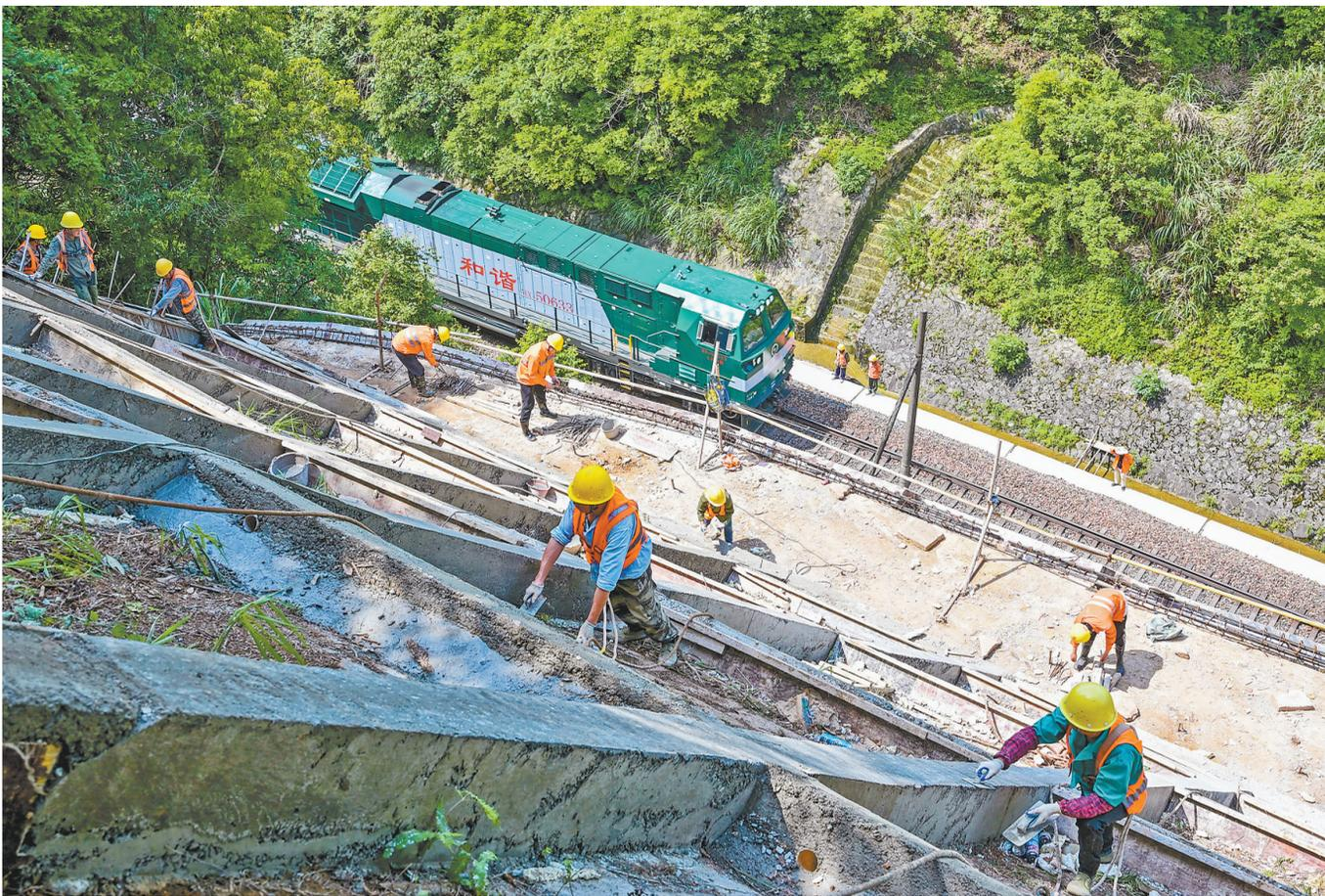
5月7日,在皖赣铁路童家埧隧道口护坡加固施工现场,工人们挂着安全绳在倾角近80度、高40余米的护坡上施工作业。
