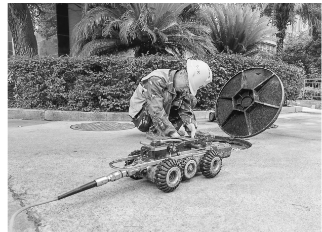
6月6日，在新余市东轩苑小区，城市雨污管网分离改造工作人员正在使用机器人对管网进行检测，加快推进雨污管网改造，增强城市水处理能力。通讯员 郭锋杰摄
