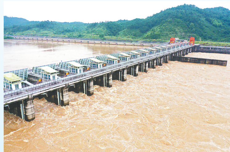
6月18日,峡江县水利枢纽18扇闸门全部开启,泄洪度汛保安全。连日来,受持续强降雨影响,赣江峡江县段水位不断上涨,该县科学调度,发挥水库调蓄作用,进行开闸泄洪。通讯员 宋靖辉摄
