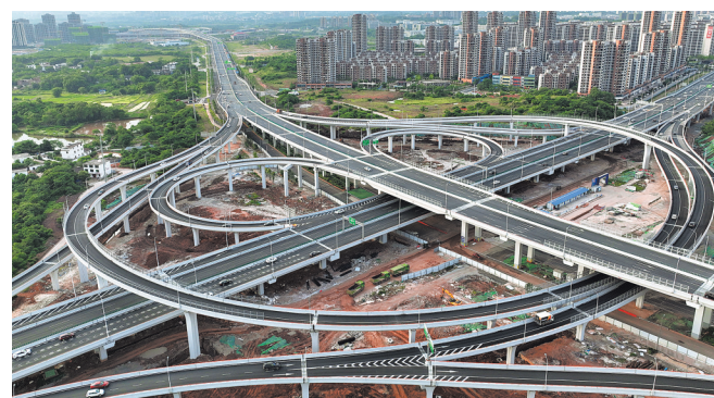
赣州市中心城区加快快速路建设，“三横三纵”快速路网基本形成。图为日前车辆行驶在赣南大道（蓉江段）。通讯员 刘凯摄
