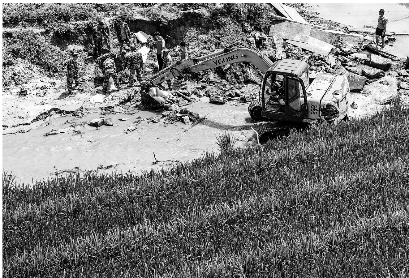
▲6月21日，南丰县傅坊乡石咀村，民兵、志愿者和村民正对因洪水导致堵塞的沟渠进行疏通和修复，保障农业灌溉用水需求。 通讯员 谢东振
