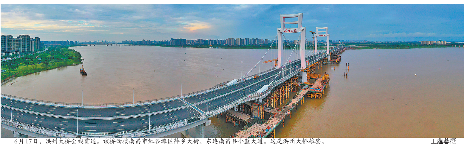
6月17日，洪州大桥全线贯通。该桥西接南昌市红谷滩区洋乡大街，东连南昌县小蓝大道。这是洪州大桥雄姿。
