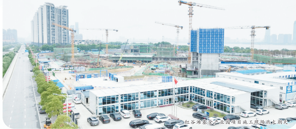
红谷滩基金产业园项目施工现场热浪朝天
