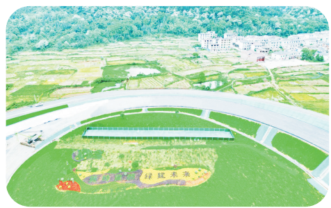
昌金高速改扩建项目宜春东枢纽
