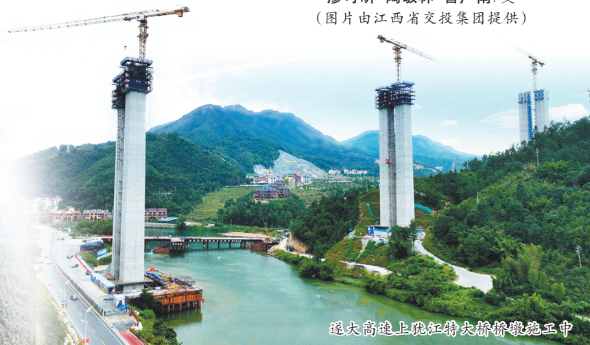
遂大高速上犹江特大桥
