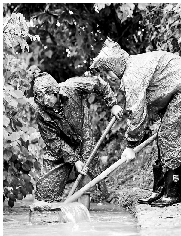
6月25日,宜春市袁州区新康府街道党员志愿者和网格员在清理铁路涵洞内的排水沟渠。新康府街道组织工作人员深入沪昆铁路沿线开展安全巡查,向群众宣传防汛护路知识,确保铁路运输安全畅通。 本报全媒体记者 邹海斌摄
