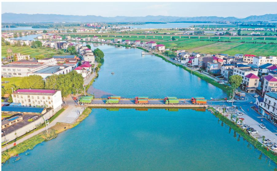
7月3日,重载货车停在彭泽县芙蓉桥上。连日来,受强降雨影响,彭泽县芙蓉河水位迅速上升,水面几乎与桥面齐平。为确保桥梁道路交通安全,7月2日下午,当地紧急调派10台总重达300吨的货车开上芙蓉桥,采取重车压梁的方式压实整个桥体,确保涨水期间桥面的牢固性。
