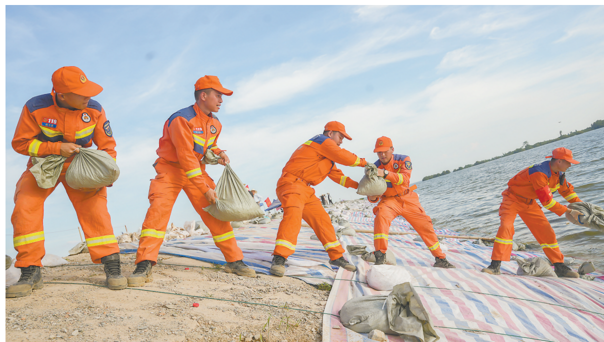
7月8日,上饶市消防救援支队水域救援专业编队在鄱阳县角半圩一线开展巡堤查险、堤坝加固等工作。队员们克服天气炎热、蚊虫叮咬等困难,通过人工接力,用沙袋对大堤进行加固。
