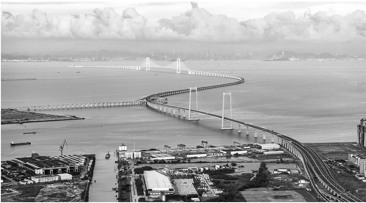
2024年6月27日拍摄的深中通道全景。
