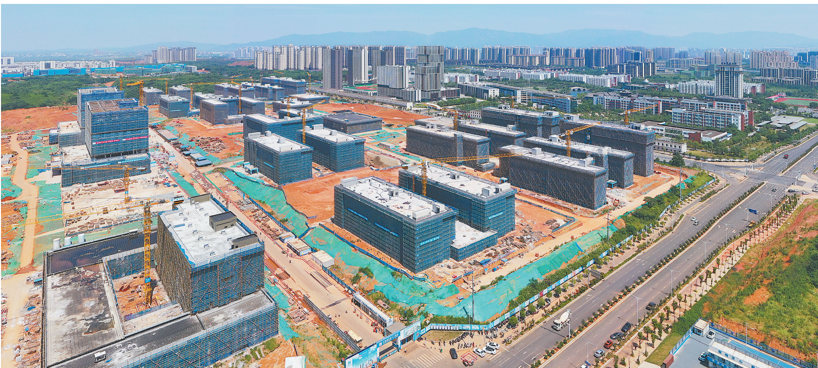
7月22日,南昌市红谷滩区未来科学城,由中建八局华中公司江西分公司承建的南昌医学院新校园(一期)项目现场,建设者们科学施工,加快推进项目建设。目前,该项目已有23栋主体建筑二次结构施工完成,进入装饰装修阶段,计划2025年2月竣工交付。
