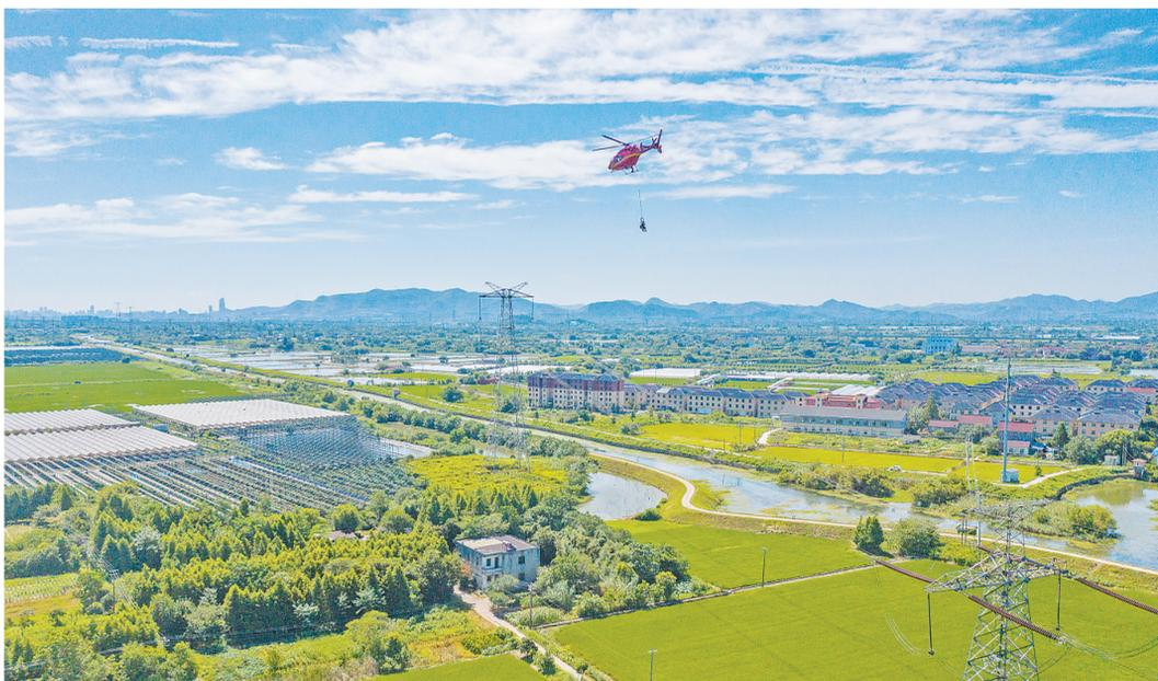
7月24日，国家电网采用直升机带电作业方式，对线路全长1000多公里的超特高压线路±500千伏宜华线、葛南线进行线路检修，保障三峡电力外送和西电东送重要输电通道平稳运行。
